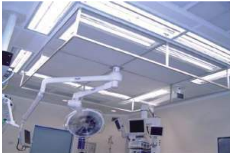
Sistema de flujo laminar
