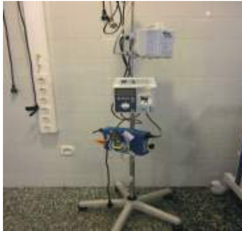
Cuadro de enchufes y toma de tierra en caso de uso de motores STRIKER o ESCOPIAS donde enchufar la lente.
